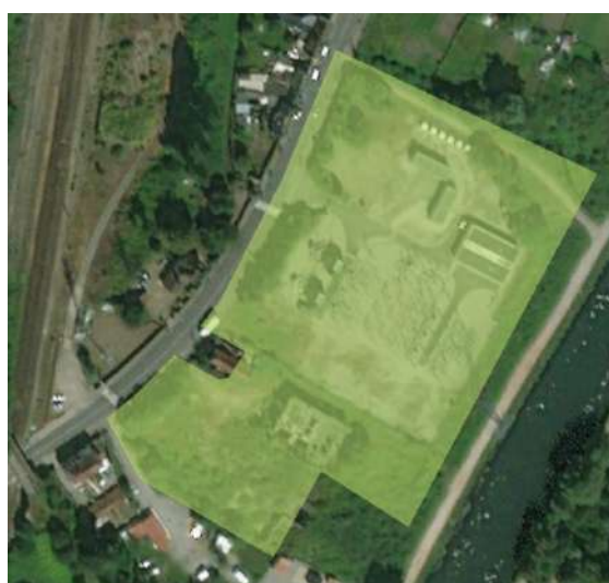
Figure 39 : Ancienne centrale EDF à Abbeville (Source : Bing Aerial)
