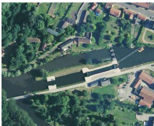
Figure 25 : Vue aérienne du barrage de Long (Source : Géoportail)
