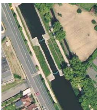
Figure 26 : Vue aérienne de l'écluse d'Abbeville (Source : Géoportail)
