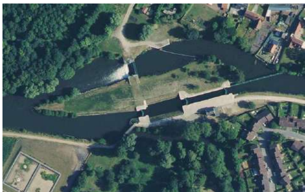
Figure 27 : Vue aérienne de l'écluse et du barrage de Pont-Rémy (Source : Géoportail)
