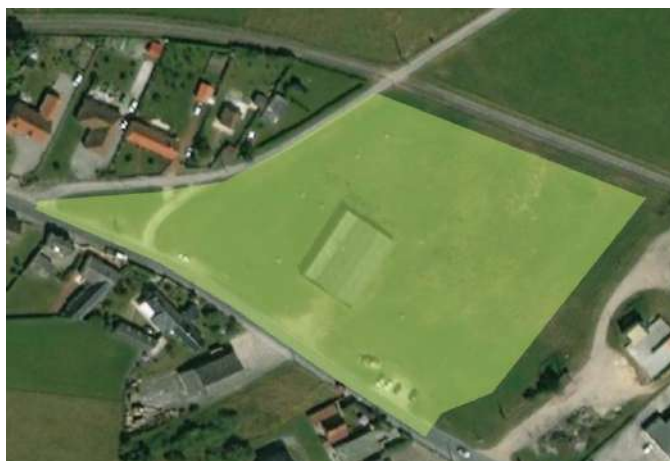
Figure 40 : Friche FTH à Cayeux-sur-Mer (Source : Bing Aerial)
